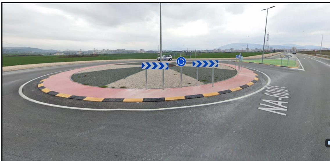
Ilustración 15. Nueva rotonda junto al colegio Irabia-Izaga (fuente street view)
